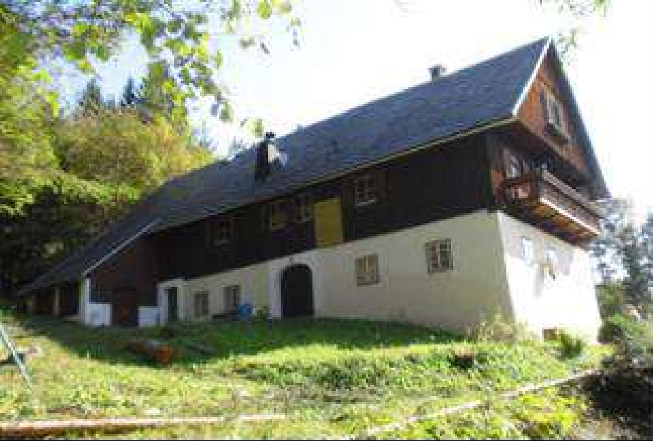
Altbestand vor Beginn der Baumaßnahmen
