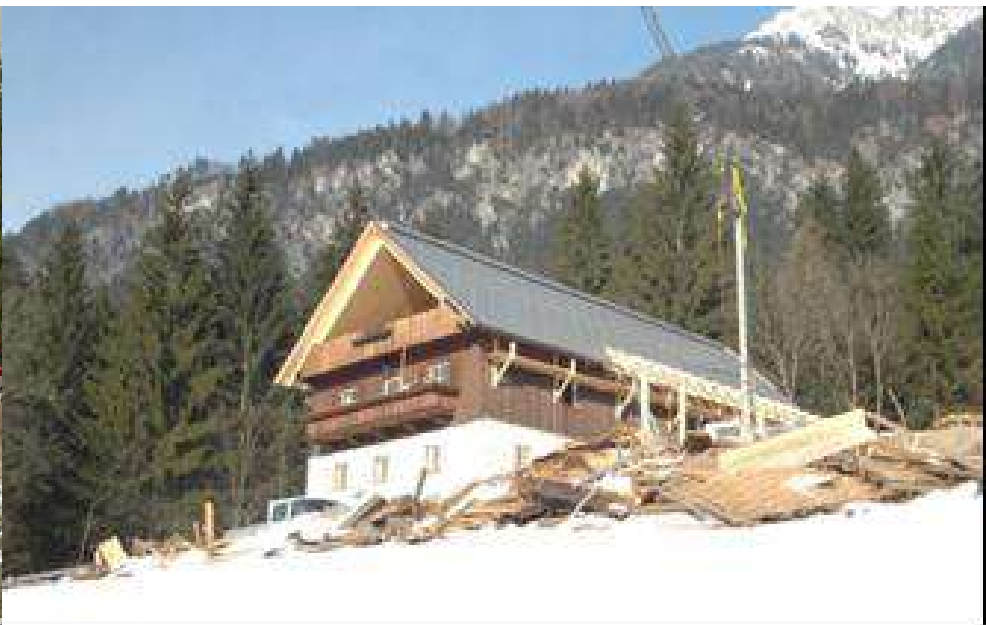
Neuer Dachstuhl samt neuer Dachdeckung
