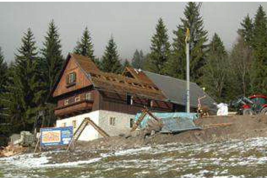
Abbrucharbeiten des alten Dachstuhles
